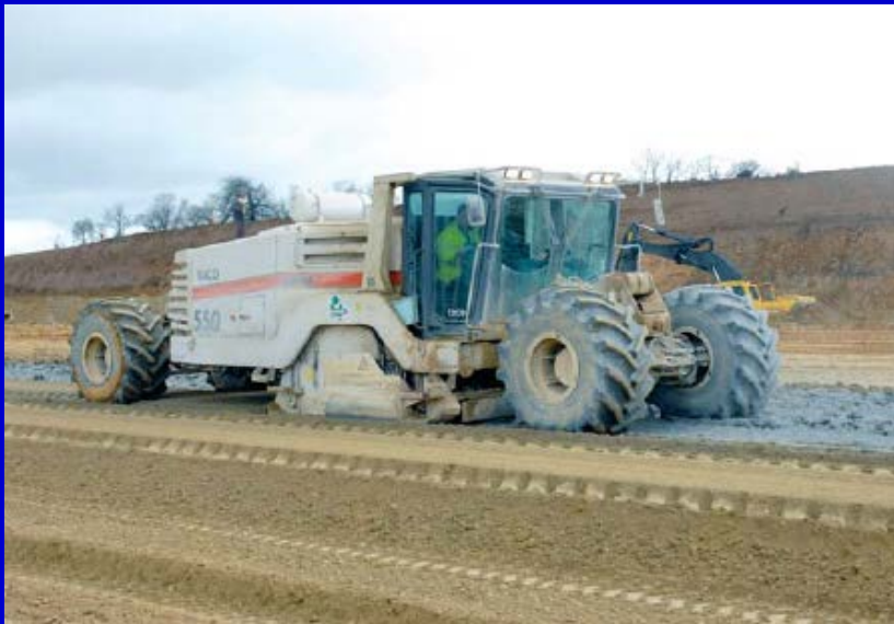
Malaxage du liant hydraulique et du sol
