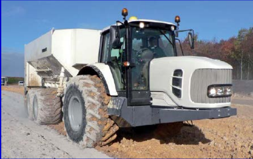
Épandage du liant hydraulique.
