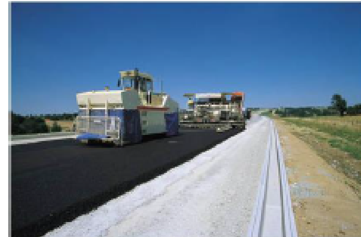
Mise en oeuvre de graves bitumes
